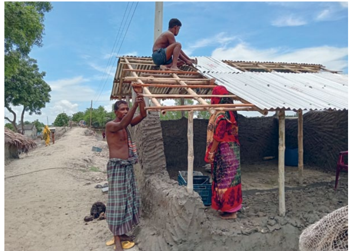
Während des Wiederaufbaus: Das Haus einer Projektteilnehmerin nach dem Zyklon „Remal“ ist inzwischen sicherer wieder aufgebaut.
